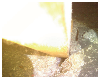
Kiilamainen tunneli vinosaudojen alla puhallusvillassa
