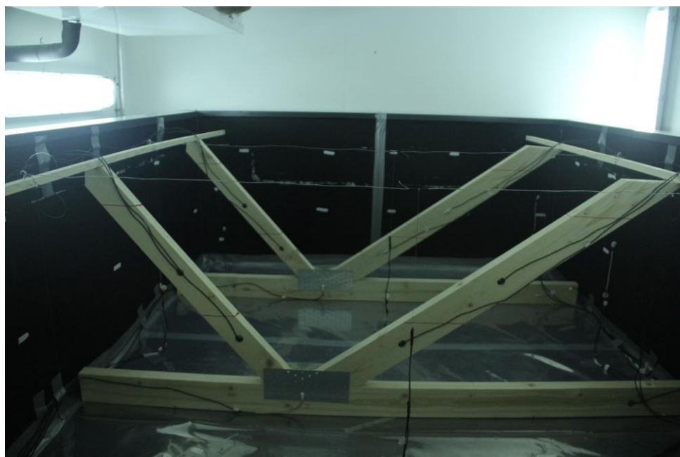
Kuva L1.2. Kuva tutkittavasta rakenteesta ennen puhallusvillan asentamista laitteiston tutkimusaukkoon.
